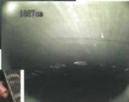
←洗管時の排水
