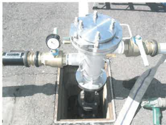
PCボール発射・受取装置(洗管口径φ150mm以下用)
